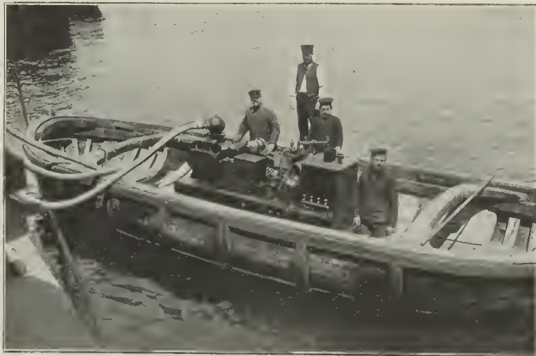
Aparato sulfurador «Masot» para la desinfección de los buques y de sus cargamentos
